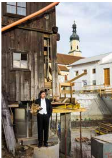
rechts Thomas Bauer an der Baustelle des Konzerthauses. daneben Das neue Bürgerhaus.
